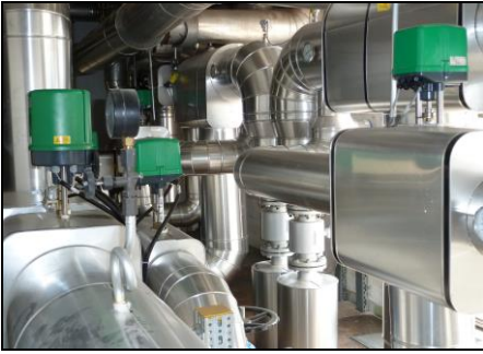
Installationen / Verrohrungen für die Heizkesselanschlüsse.
