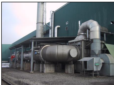
Abhitzekessel, mit sehr unregelmässiger Wärmeproduktion.
